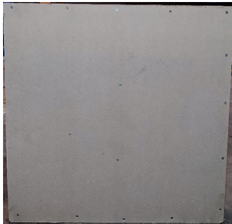
Figura 8. Vista de la probeta N°1 antes del ensayo, cara expuesta al fuego.
